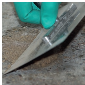
Vyplnění lokálních poruch MC-Floor TopSpeed SC plnění pískem
