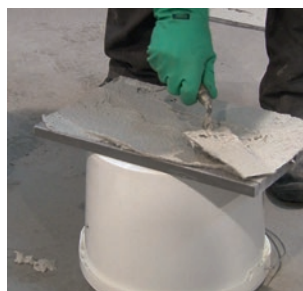
Celoplošné nanesení lepidla
