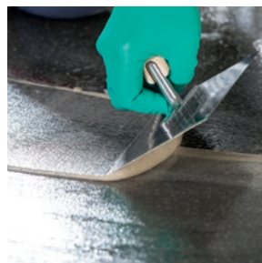
Vystěrkování a uzavření podkladu MC-Floor TopSpeed SC plnění pískem
