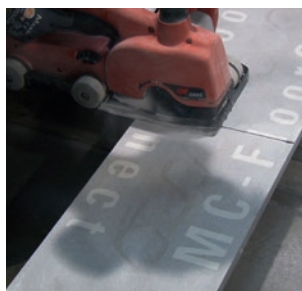
Jednoduchý přířez na stavbě
