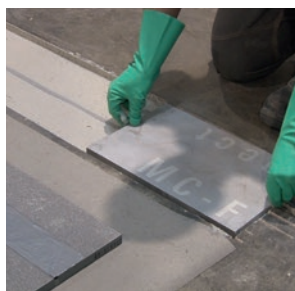
Pokládka profilu do lepícího lože
