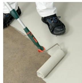
Vysoce zatížitelná finální vrstva nanesená válečkem MC-Floor TopSpeed
